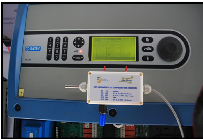
รูปที่ 4 อุปกรณ์ประมวลค่าความชื้นและอุณหภูมิสำหรับโรงเลี้ยงโก-เปิด
